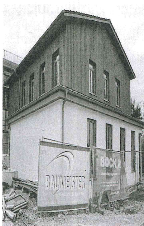
Der östliche Anbau an die Turn- und Festhalle lässt bereits erkennen, wie groß und modern das Gebäude bald sein wird. Foto: Claudia Bader
